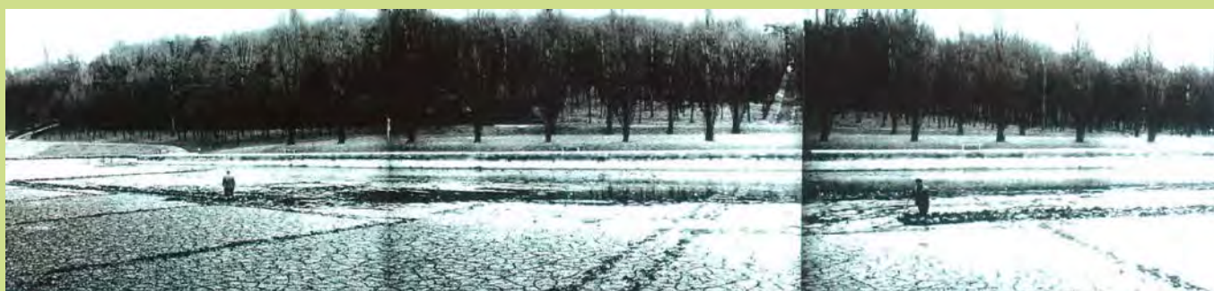
Photo 5. Travaux de curage des pièces d'eau 1955
